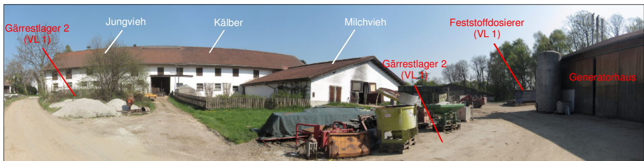
Abbildung 4-4: Panoramaaufnahme der Biogasanlage und der Rinderhaltung Bauer mit Blick nach Nordwest (linker Bildrand) bis Ost (rechter Bildrand). (VL = Verfahrenslinie, siehe Kapitel 5 „Beschreibung der Biogasanlage“)
