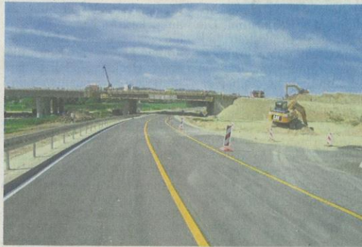
Die ED 12 im Bereich der A 94-Trasse ist wieder für den Verkehr frei.
