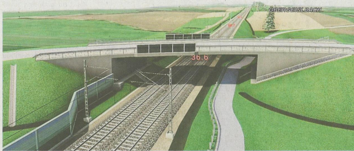
Eine Straßenüberführung bei Obergeislbach mit einer Spannweite von 24 Metern plant die DB. Die Gemeinde Lengdorf ist zwar nicht zuständig für die Baukosten, aber für den Unterhalt und mögliche spätere Baukosten. GRAFIK: DB INFRAGO
